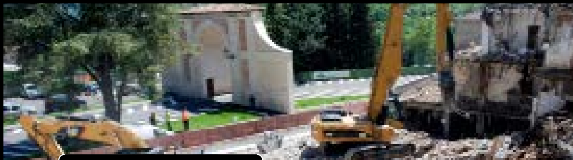
Opere di demolizione e ricostruzione edificio zona Porta Napoli_L'AQUILA
