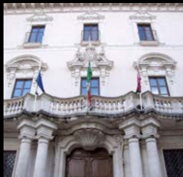
Lavori di messa in sicurezza di Palazzo Centi_L'Aquila
